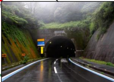
愛媛県 大久トンネル
