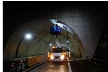
点検状況 (近接目視+打音検査)
