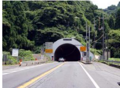
豊岡河川国道 蒲生トンネル
