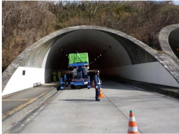
写真1. 片側規制での作業
