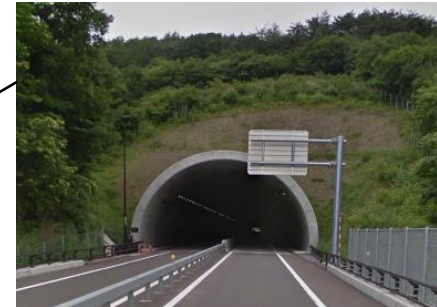
磐城国道 新玉野トンネル+他2トンネル
