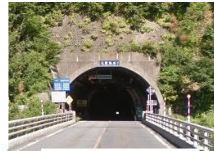
高崎河川国道 三国トンネル
