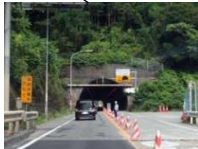
沼津河川国道 城山トンネル+他2トンネル
