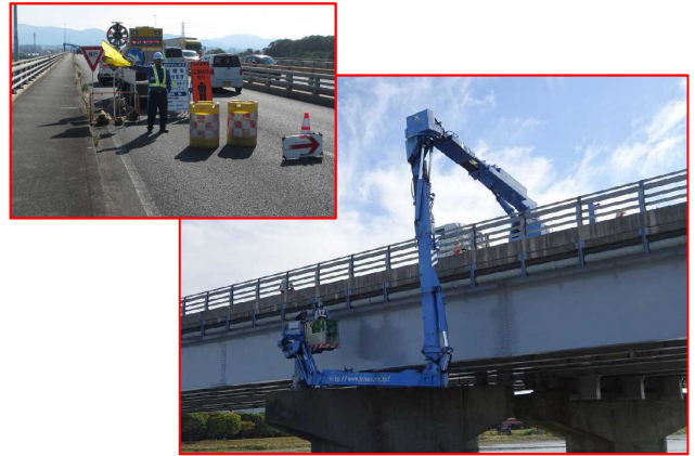
通行規制を実施し、橋梁点検車で近接目視点検
