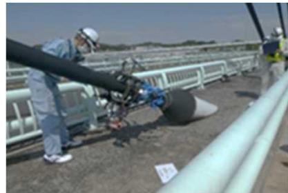
実橋のケーブルでの検証
