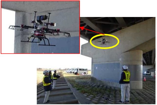
ドローンにより写真を撮影し画像から損傷を確認
