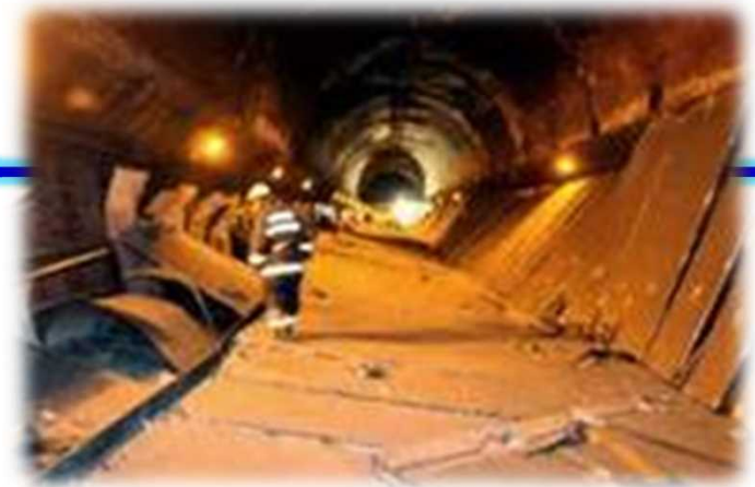
笹子トンネル事故 (2012年12月)
