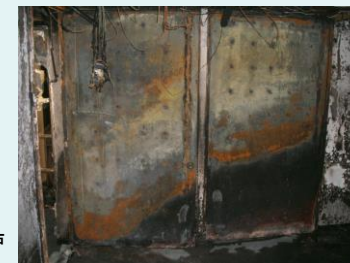
1階階段室の防火戸
