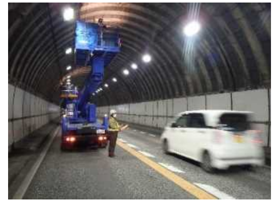
通行規制を実施し、トンネル内を打音検査
