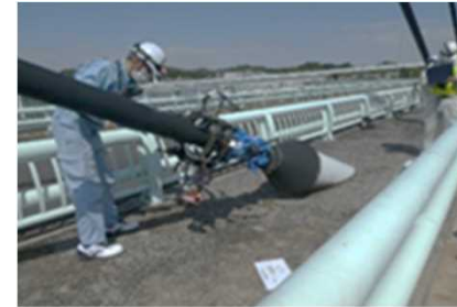
実橋のケーブルでの検証
