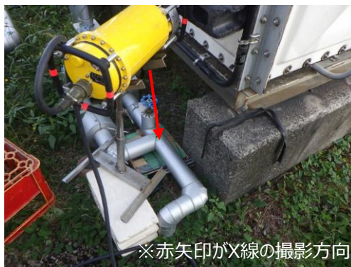
X線透過検査の様子（ラッキングの上から撮影）
