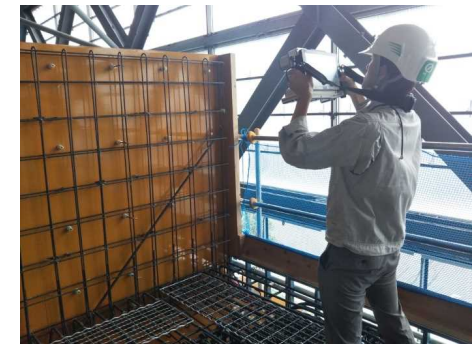
配筋検査システムによる計測の様子
