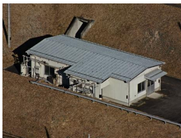
図 3.2-10 も近い確認可能ポイント (ポイント 3 高度 100) からの写真 (危険工室)
