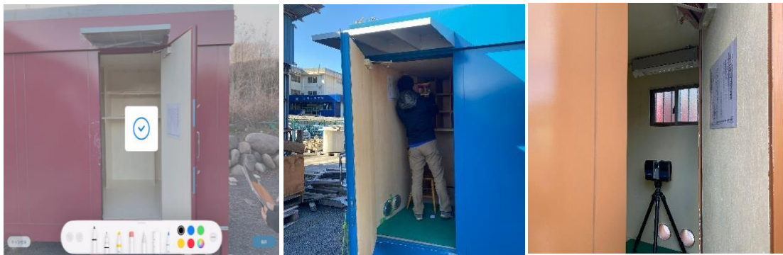
図 2.2-6 火薬類製造施設の類似設備（火薬類取扱所（左）、火工所（中・右））
