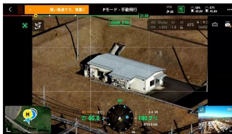
図 3.2-12 確認可能ポイントからの写真 (危険工室) (ポイント 3 高度 100)
