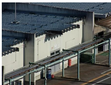
図 3.2-9 も近い確認可能ポイント (ポイント 3 高度 40) からの写真 (危険工室)
