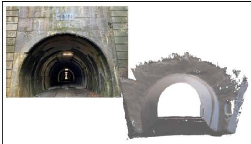
図 2.1-4 複雑 3 次元形状のトンネルを点群データに変換した例 (株式会社エム・ソフト デジスキャン ホームページより引用)
