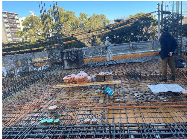
写真-7 反町 2F の現場写真
