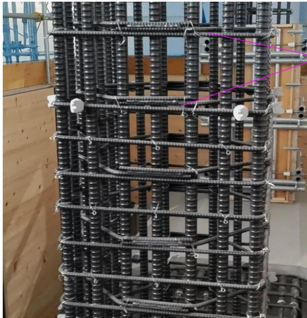
複数鉄筋が隣接して並行配置
