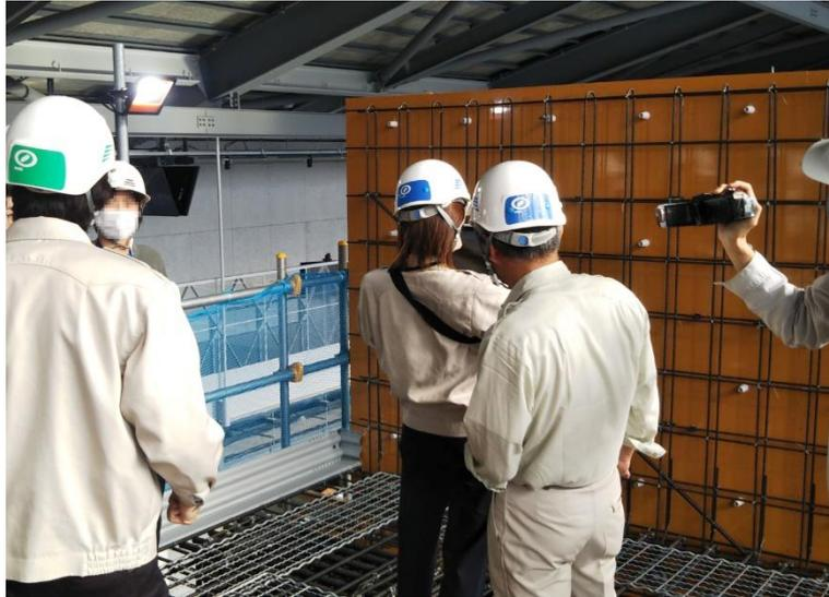
図 27 配筋検査システムに慣れていない作業による計測の様子
