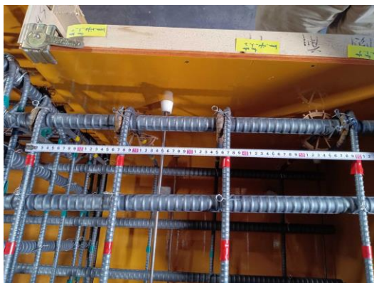
図 13 従来手法 (メジャーによる測定)
