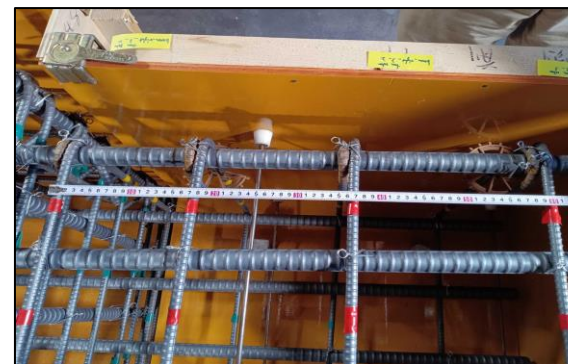
図5 従来手法（メジャーによる鉄筋間隔の計測）
