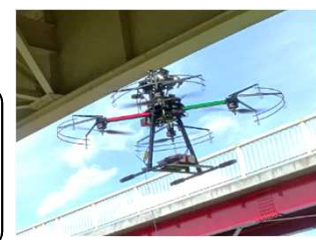
ドローンによる損傷把握
