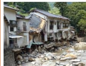
<平成29年台風18号等での基礎・地盤被害による住家被害の例>
