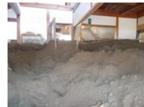
<平成29年九州北部豪雨での土砂堆積等による住家被害の例>
