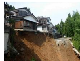
<平成29年台風18号等での基礎・地盤被害による住家被害の例>
