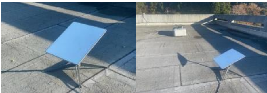
図 35 Starlink のアンテナ(左)と設置されたポート及び Starlink のアンテナ(右)
