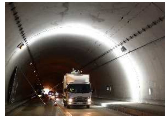
レーザー計測により、背面空洞や内部損傷(うき)を確認
