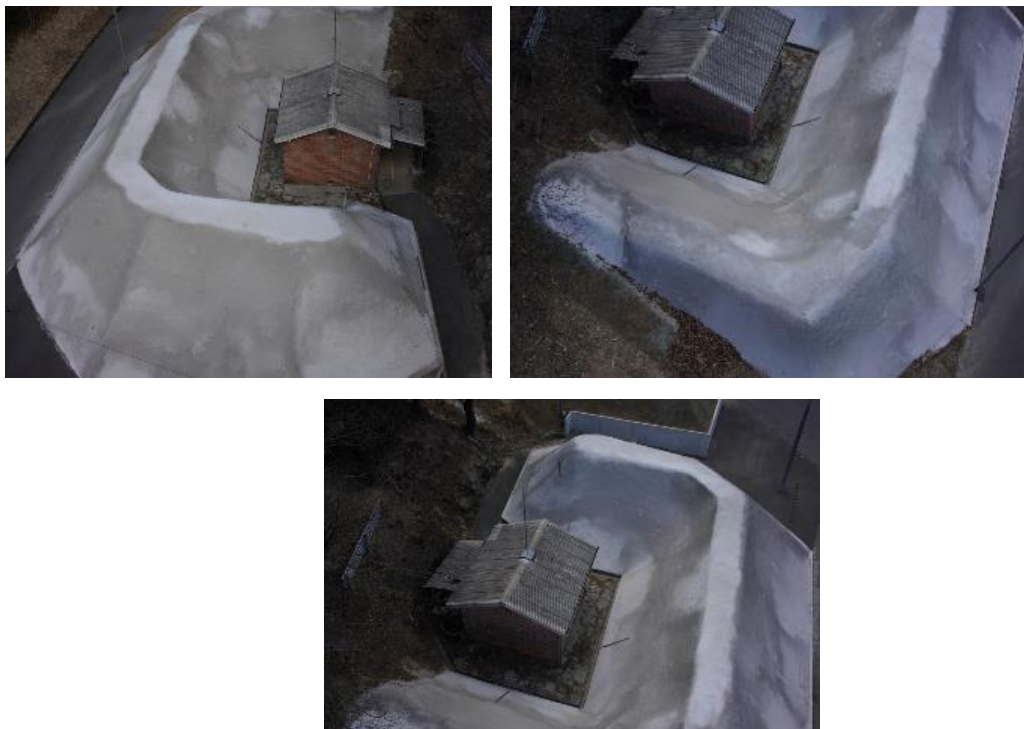
図 17 ドローンにて撮影した画像による確認
