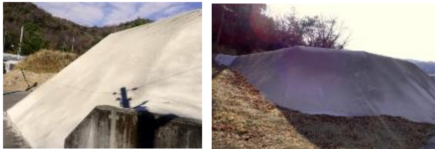
図 12 対象となる土堤の日向・日陰の様子
