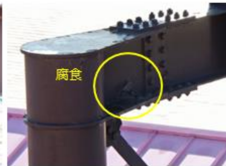
A1 部 15 番梁の腐食 (手動検査／自動検査)
