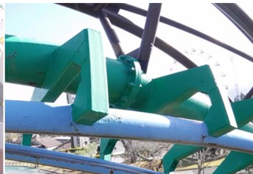
A2 部スパイラル上部桁取付け部分（手動検査） ボルトと合いマーク
