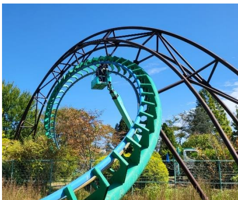
図 38 検査員が構造部材・補助部材・軌条を目視確認する様子（コースター）
