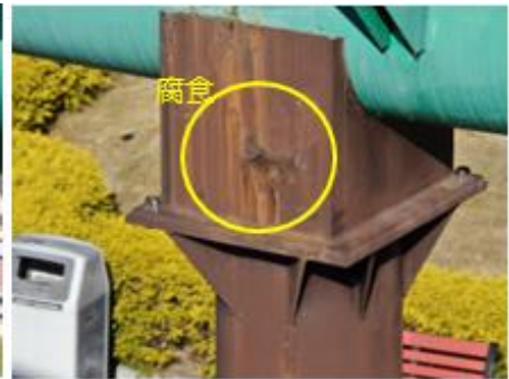
A1 部 14 番柱の腐食 (手動検査／自動検査)
