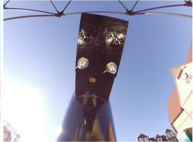
模擬劣化サンプル品 構造部材下面 (ELIOS3) 標準搭載のカメラで十分に撮像可能であった。
