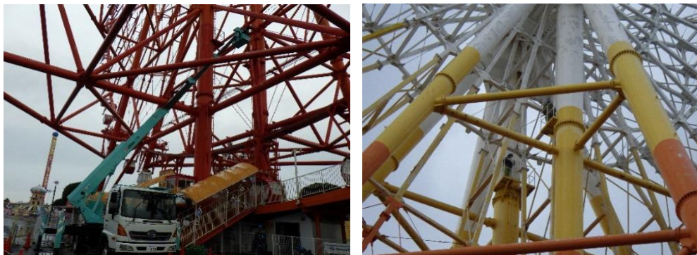
図 47 検査員が構造部材・補助部材を目視確認する様子（観覧車）
