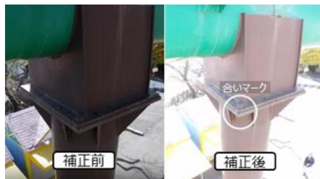
A1 部 14 番柱（手動検査） 露出補正によって合いマークを 確認することができた
