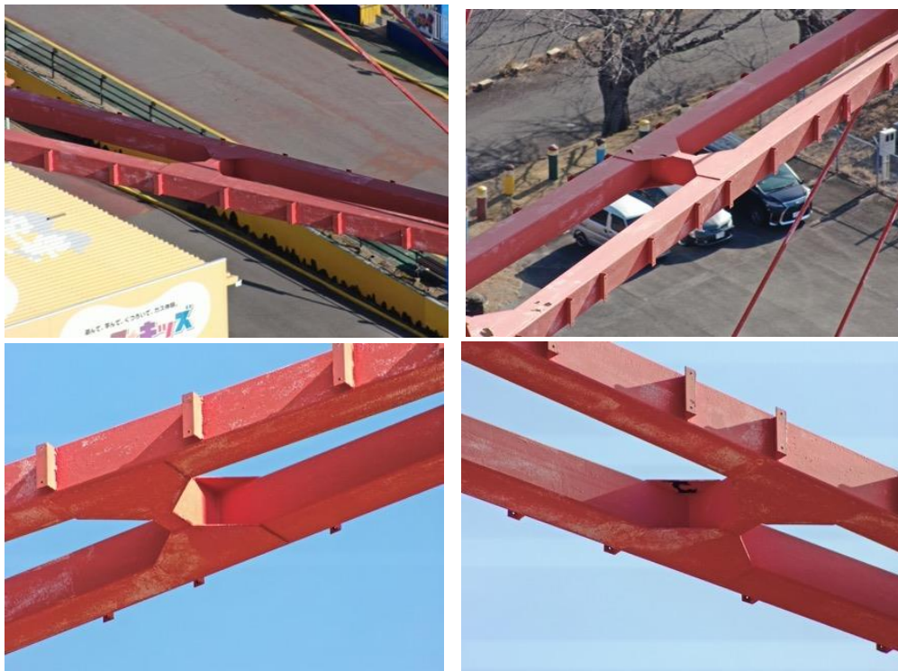
図 52 接合部における上下左右の方向からの撮影結果（観覧車）
