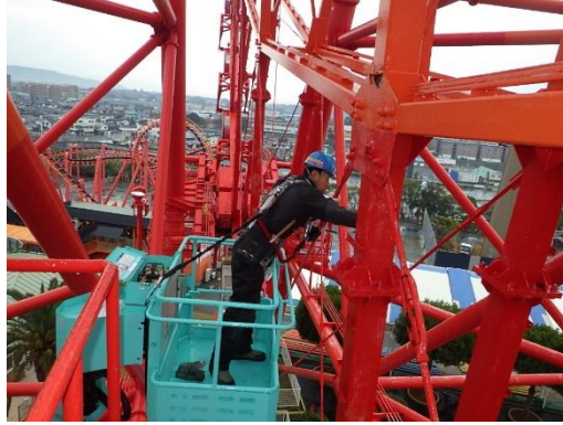
図 48 検査員が接合部分を目視確認する様子（観覧車）
