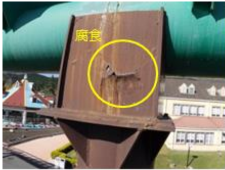
A1 部 14 番柱の腐食 (手動検査／自動検査)
