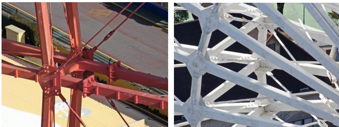
図 49 ドローンによる取付け部撮影結果（観覧車）
