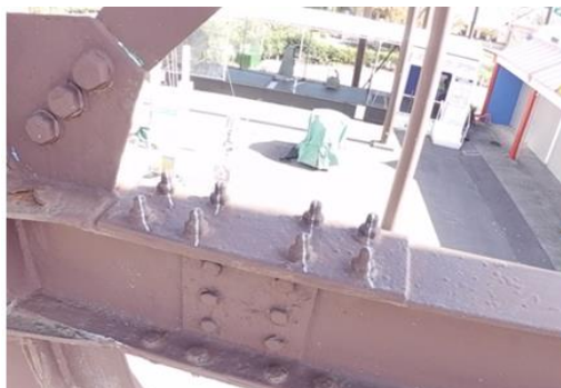
A1 部 15 番梁・梁取付け部分（手動検査） ボルトと合いマーク
