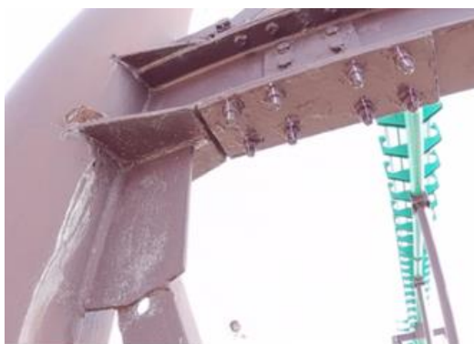
A1部 13番柱・梁（手動検査） 構造物下面（裏面）の撮像には視野角 （特に仰角）が大きく関与する
