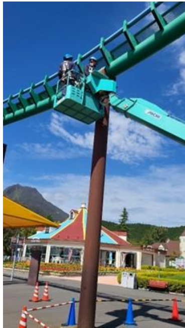
図 37 検査員が接合部分を目視確認する様子(コースター)
