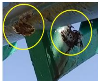
A2 部スパイラル上部 自動検査時には発見できなかった スパイラル上部の 2 つの顕著な腐食
