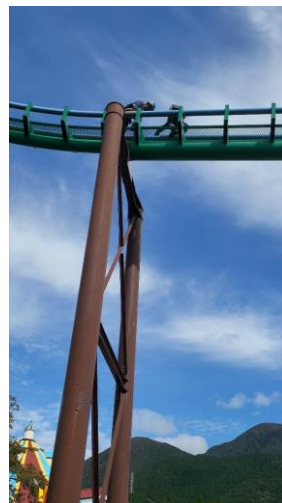
図 38 検査員が構造部材・補助部材・軌条を目視確認する様子（コースター）
