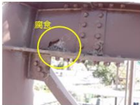
A1 部 15 番梁の腐食 (手動検査／自動検査)
