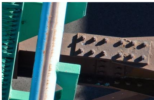
A1 部 13 番柱・梁取付け部分（自動検査） ボルトと合いマーク
