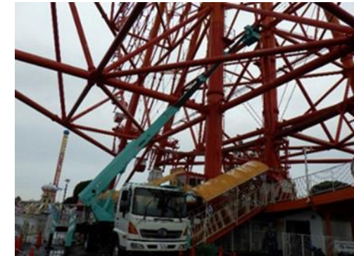
図9 観覧車における人的検査の様子
