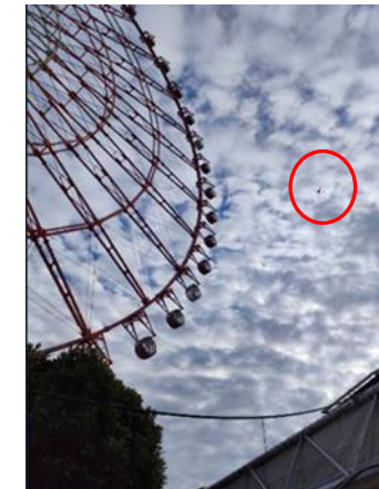
図10 観覧車におけるドローン検査の様子
