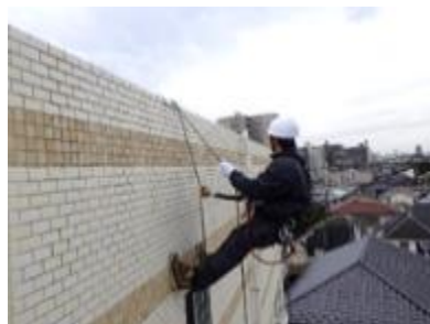
図 1 打診点検の状況
