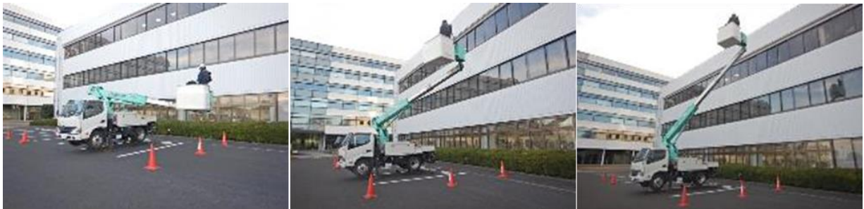
図 65 建築物近傍電波発信調査作業状況（ドローン未搭載）
