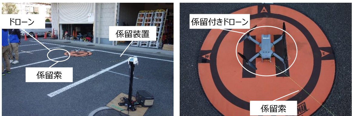
図 29 「1点係留」設置状況 (左)係留装置全景、(右)係留状態のドローン
