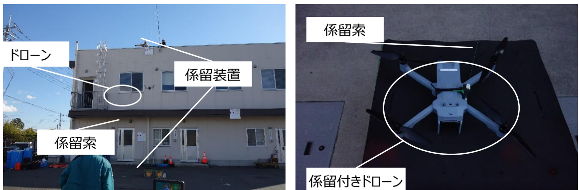
図 30 「2点係留」設置状況 (左)係留装置全景、(右)係留状態のドローン
