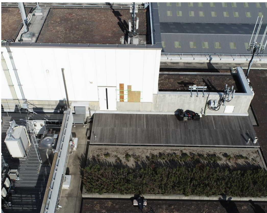
図 125 壁面に板材を張りつけた状態(左：コンパネ 12 mm、右：ベニヤ板：5 mm)
