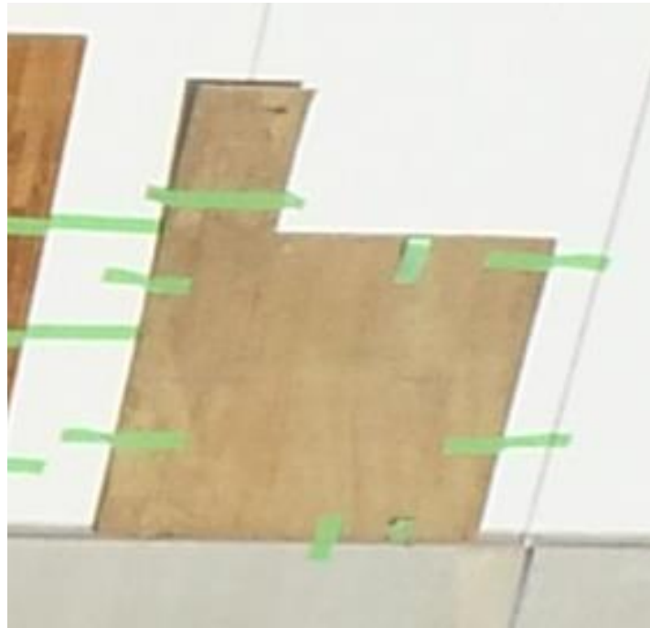
図 137 ベニヤ板の設置状況
