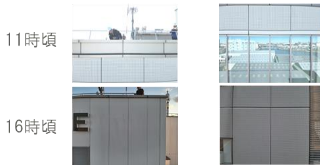
図 181 撮影時刻の異なる画像の例(北面)
