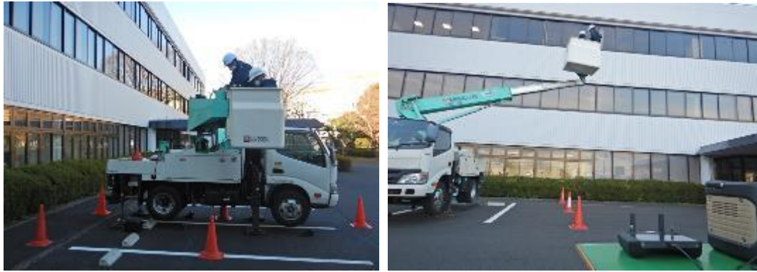
図 67 建築物近傍電波干渉調査作業状況（ドローン搭載）
