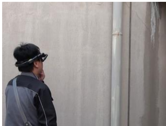
図33 遠隔点検（スマートグラス）の様子
