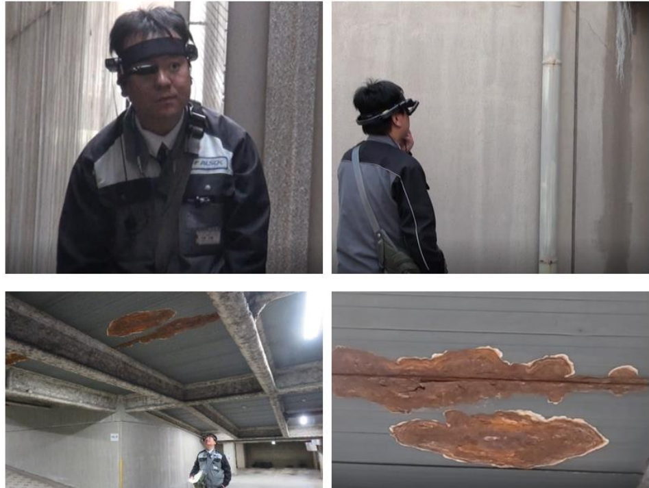
図 83 点検実施状況（遠隔点検：外周（左上）、遠隔点検：屋上（右上）、遠隔点検：屋内駐車場（左下）、スマートグラス撮影画像（右下））
