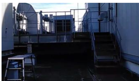
図 75 ALSOK 稲城ビルの屋上
