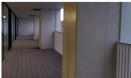
図 77 ALSOK 稲城ビルの2階（バルコニー）
