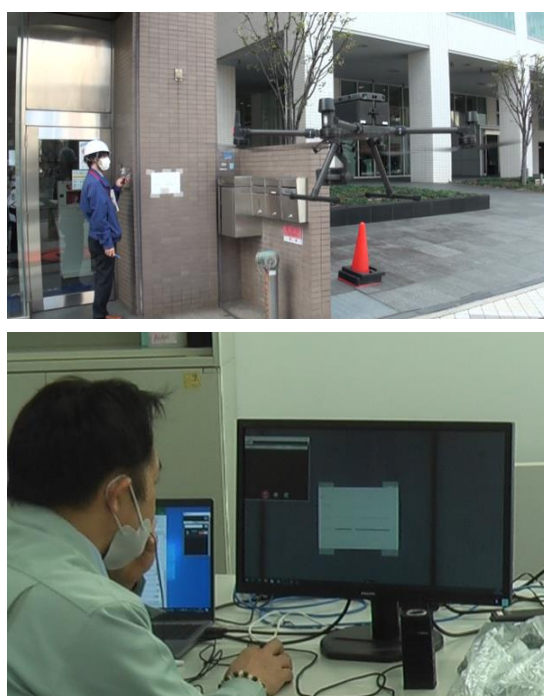
図 48 遠隔点検（ドローン）の標準撮影距離の設定の様子
