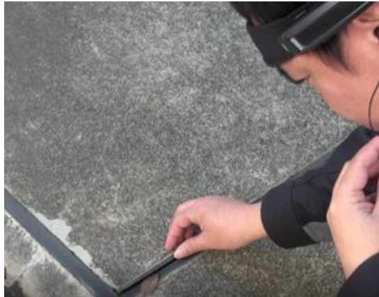
図 42 遠隔点検（スマートグラス）の様子
