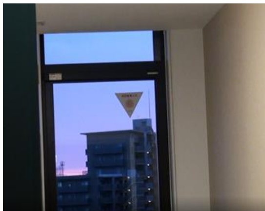
図 79 ALSOK 稲城ビルの4階（非常用進入口）
