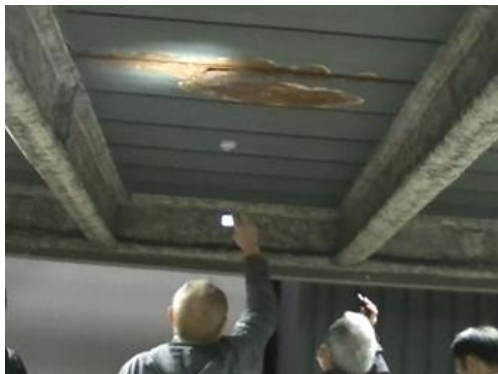
図 32 実地点検の様子
