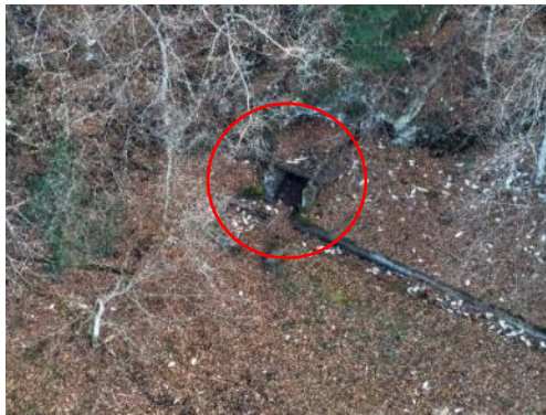
e. 第一堆積場の排水口の撮影像
