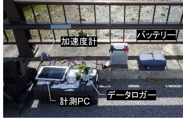
センサーを活用したたわみ計測
