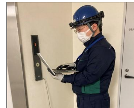
保守点検ツールでの測定
