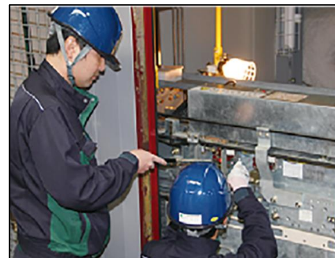
検査員による従来手法による測定 (目視・メジャーによる測定)
