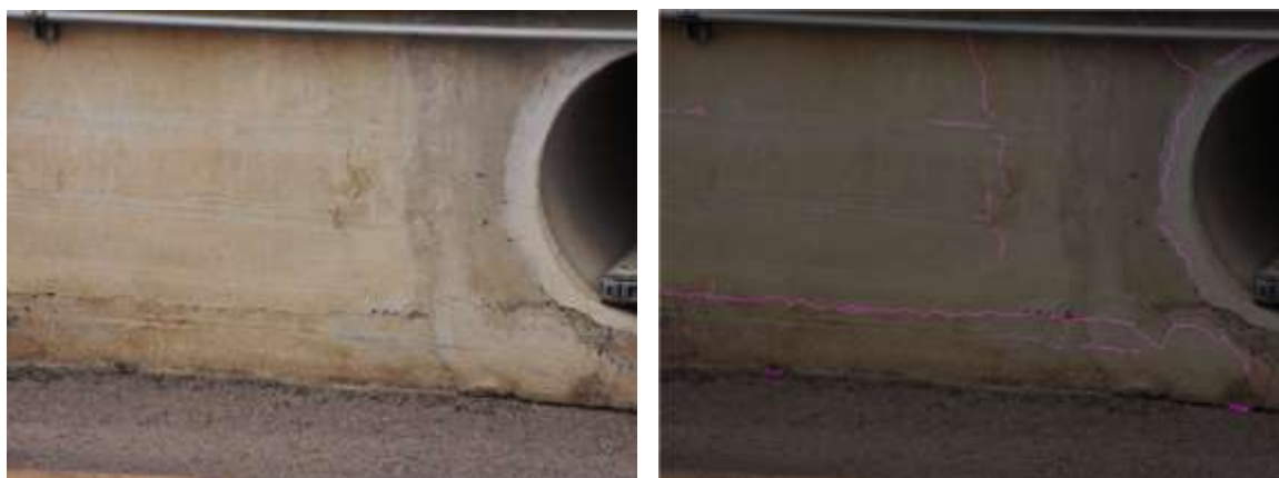
図 126 建物の基礎のひびの AI 解析結果
