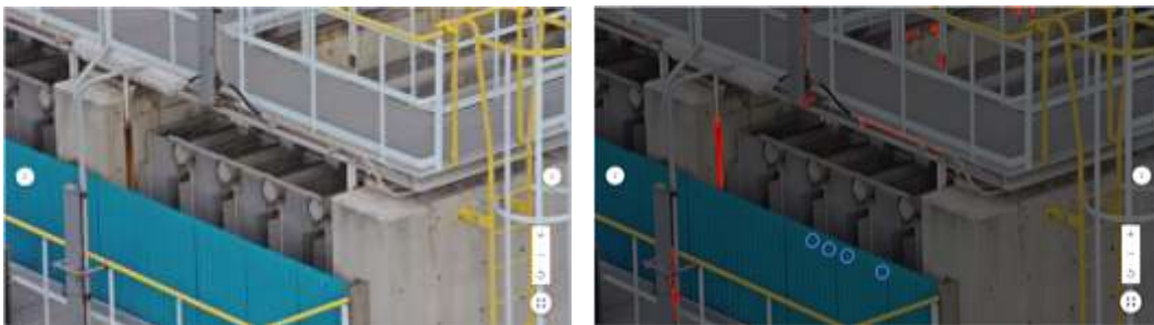
図 135 LNG 気化器正面の錆の AI 解析結果
