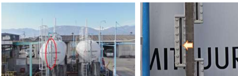
図 85 LPG 貯槽の液面計の撮影結果(矢印までが液量) (左側:全景、右側:左の赤丸箇所の拡大図)
