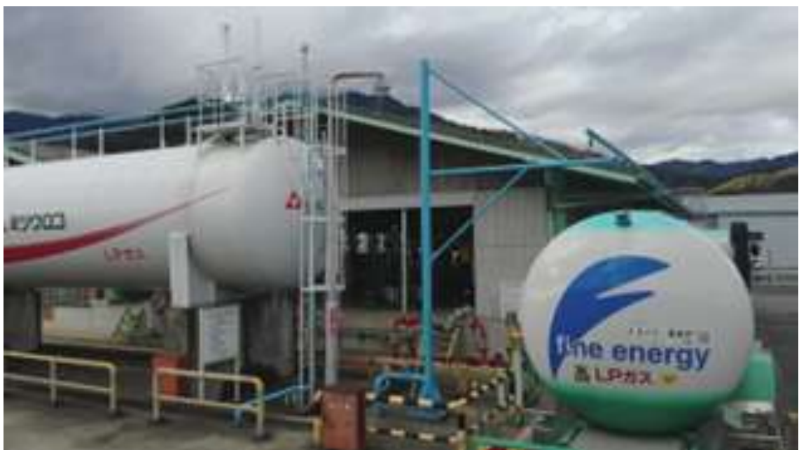
図 31 貯槽周辺の点検
