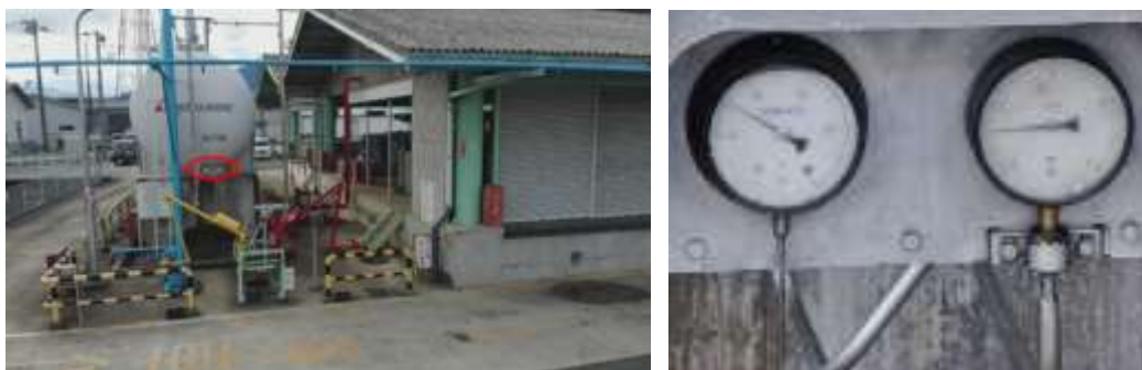
図 84 LPG 貯槽の前面のメーターの撮影結果(左側:全景、右側:左の赤丸箇所の拡大図)
