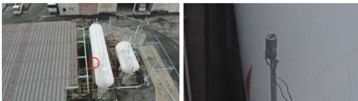
図 106 配管の上面の放出管(・レインキャップ)の撮影結果 (左側:全景、右側:左の赤丸箇所の拡大図)
