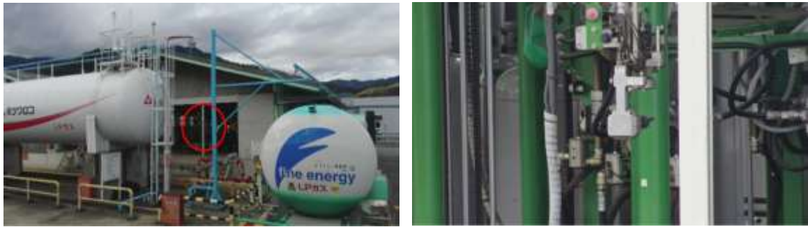
図 58 充てん機の錆撮影結果(田富事業所 左側:全景、右側:左の赤丸箇所の拡大図)
