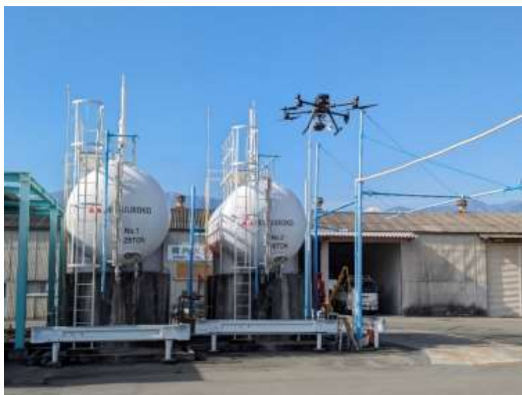
図 35 貯槽の点検
