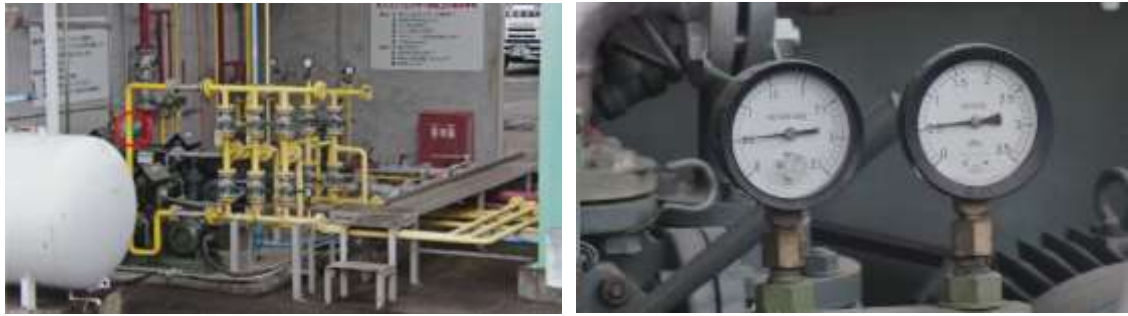
図 90 圧縮機に設置されているメーターの正面からの撮影結果 (左側:全景、右側:左の赤丸箇所の拡大図)
