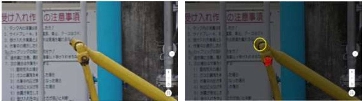
図 127 ローディングアームの接合部分の錆の AI 解析結果
