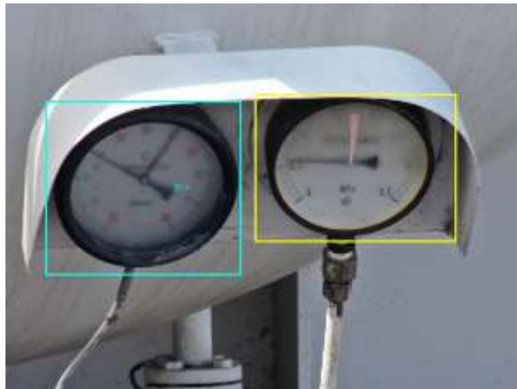
図 119 LPG 貯槽の前側のメーターの AI 解析結果
