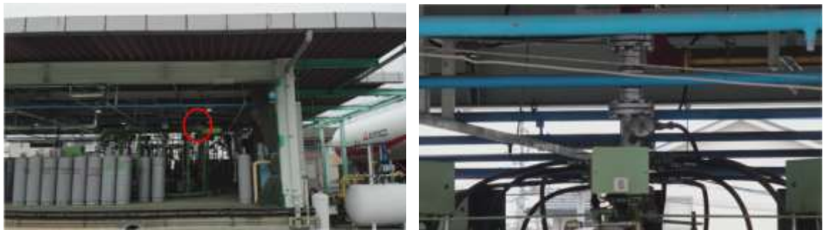
図 59 充てん機の回転部分（スイベル）の撮影結果 (左側:全景、右側:左の赤丸箇所の拡大図)
