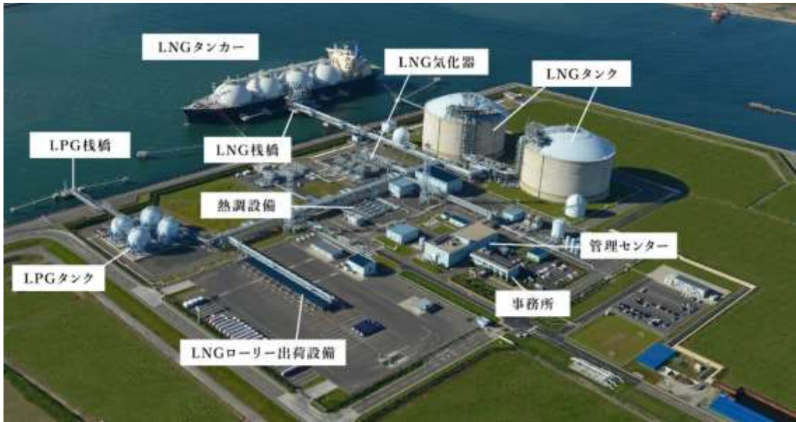
図 18 ひびき LNG 基地全景（ひびきエル・エヌ・ジーホームページ・ひびきエル・エヌ・ジー株式会社・閲覧日 2024/01/30・ https://www.hibiklng.co.jp/terminal.html ）
