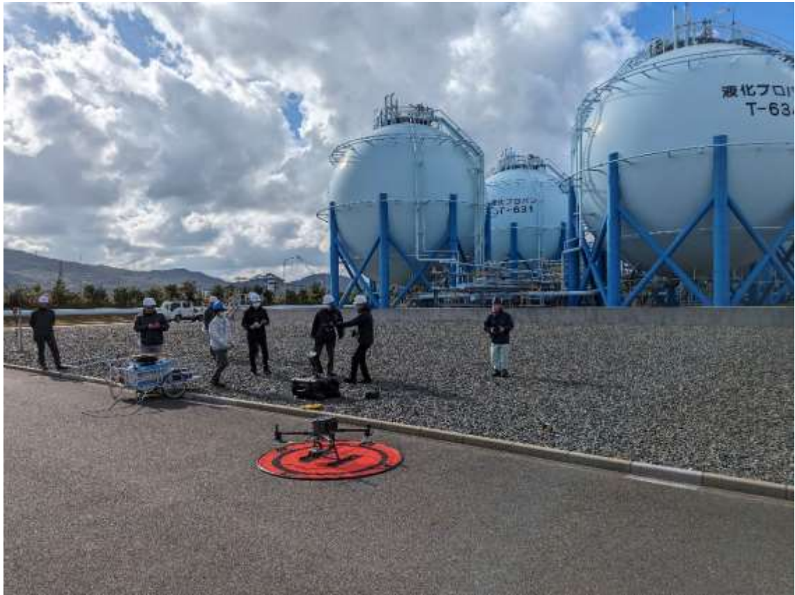
図 24 LPG 貯槽の点検
