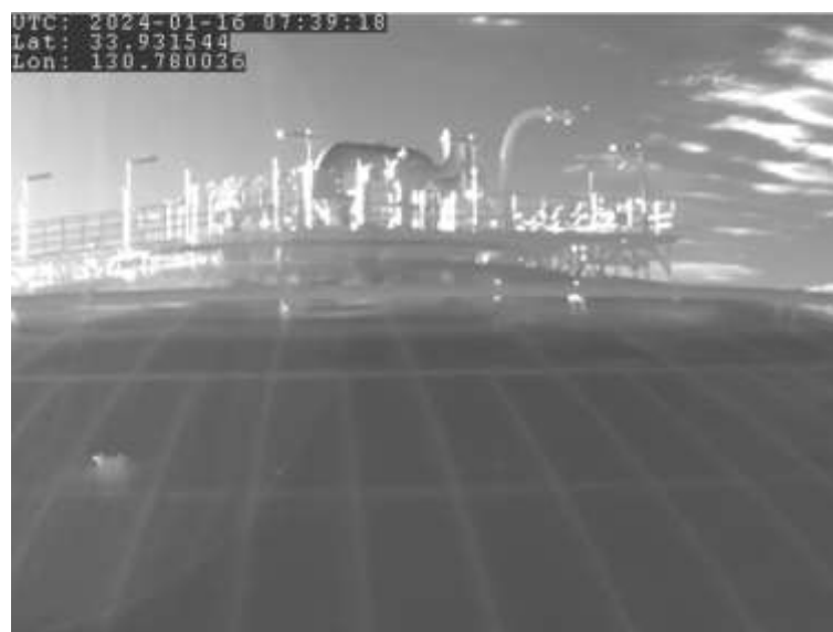
図 102 ひびき LNG 基地におけるガス検知カメラでの撮影の様子
