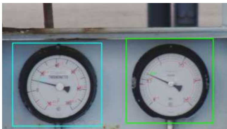
図 140 LPG 貯槽に設置されているメーターの AI 解析結果
