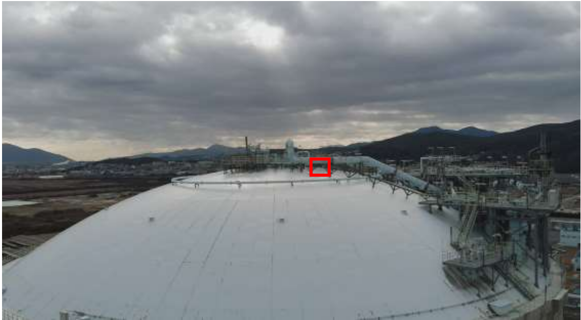
図 20 貯槽上部を広角カメラで撮影した様子（図 18 は赤枠部分をズームカメラで撮影）
