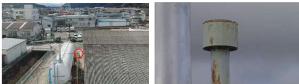
図 105 配管の上部の放出管(・レインキャップ)・側面の撮影結果 (左側:全景、右側:左の赤丸箇所の拡大図)
