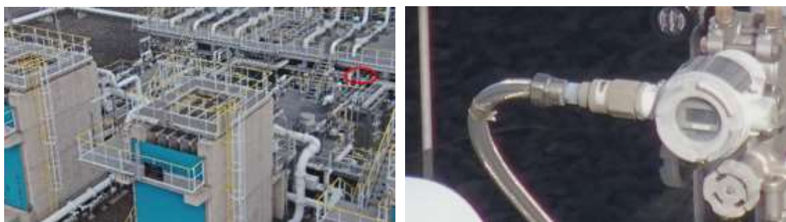
図 94 LNG 気化器に設置されているデジタルメーターの撮影結果 (左側:全景、右側:左の赤丸箇所の拡大図)
