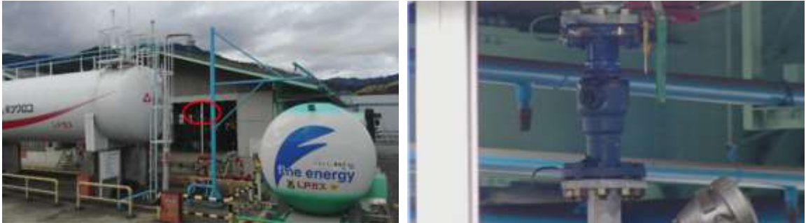
図 107 充てん機の上部の回転部分(スイベル)の撮影結果 (左側:全景、右側:左の赤丸箇所の拡大図)
