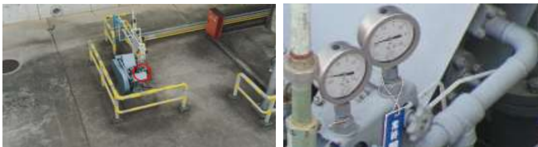
図 89 圧縮機に設置されているメーターの斜め上からの撮影結果 (左側:全景、右側:左の赤丸箇所の拡大図)
