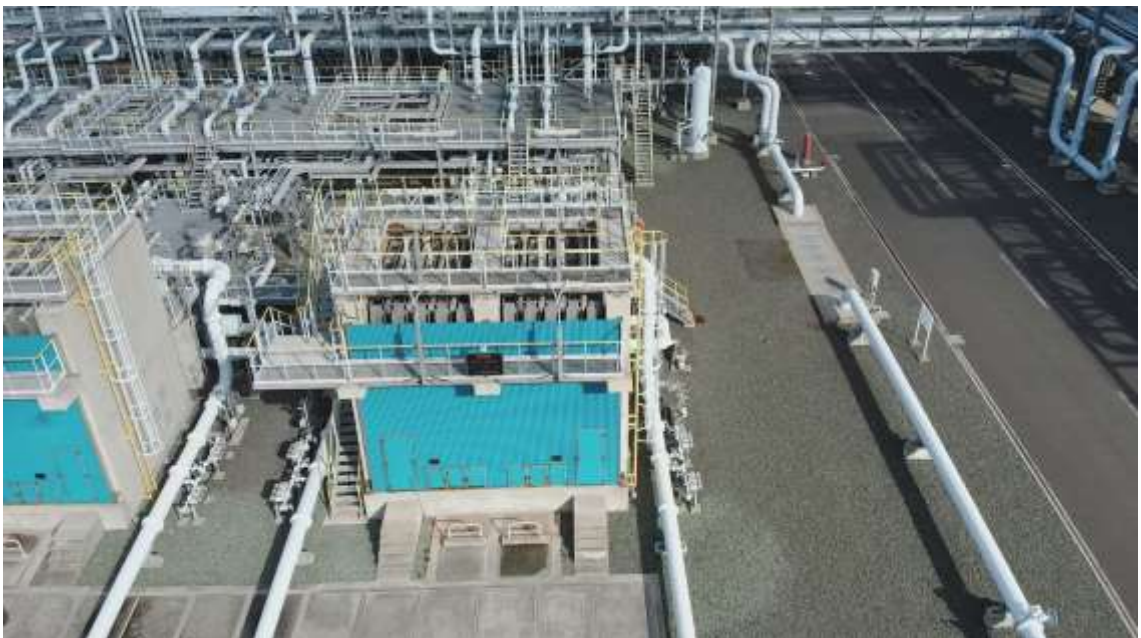
図 27 気化器を上空から撮影した様子
