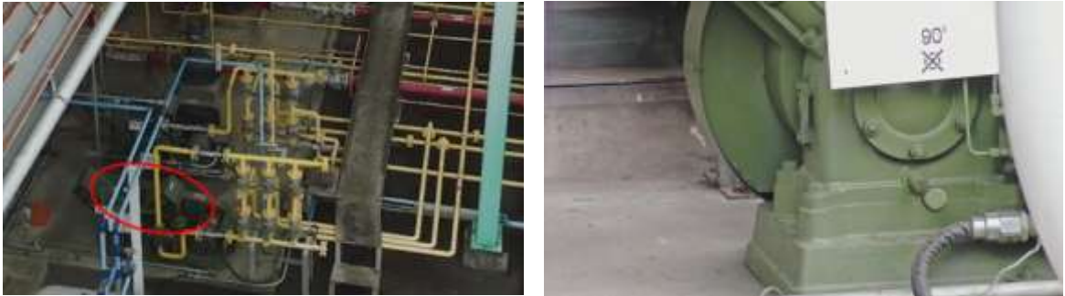
図 65 圧縮機の下部の撮影結果(左側:全景、右側:左の赤丸箇所の拡大図)
