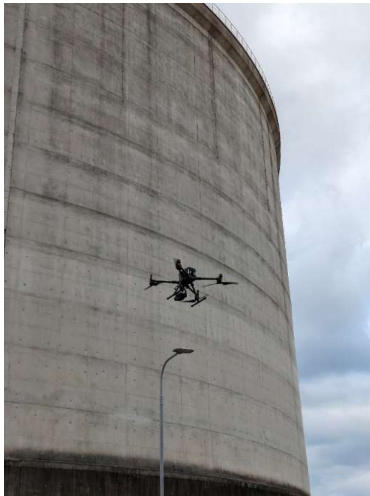
図 19 LNG 貯槽を点検中の様子
