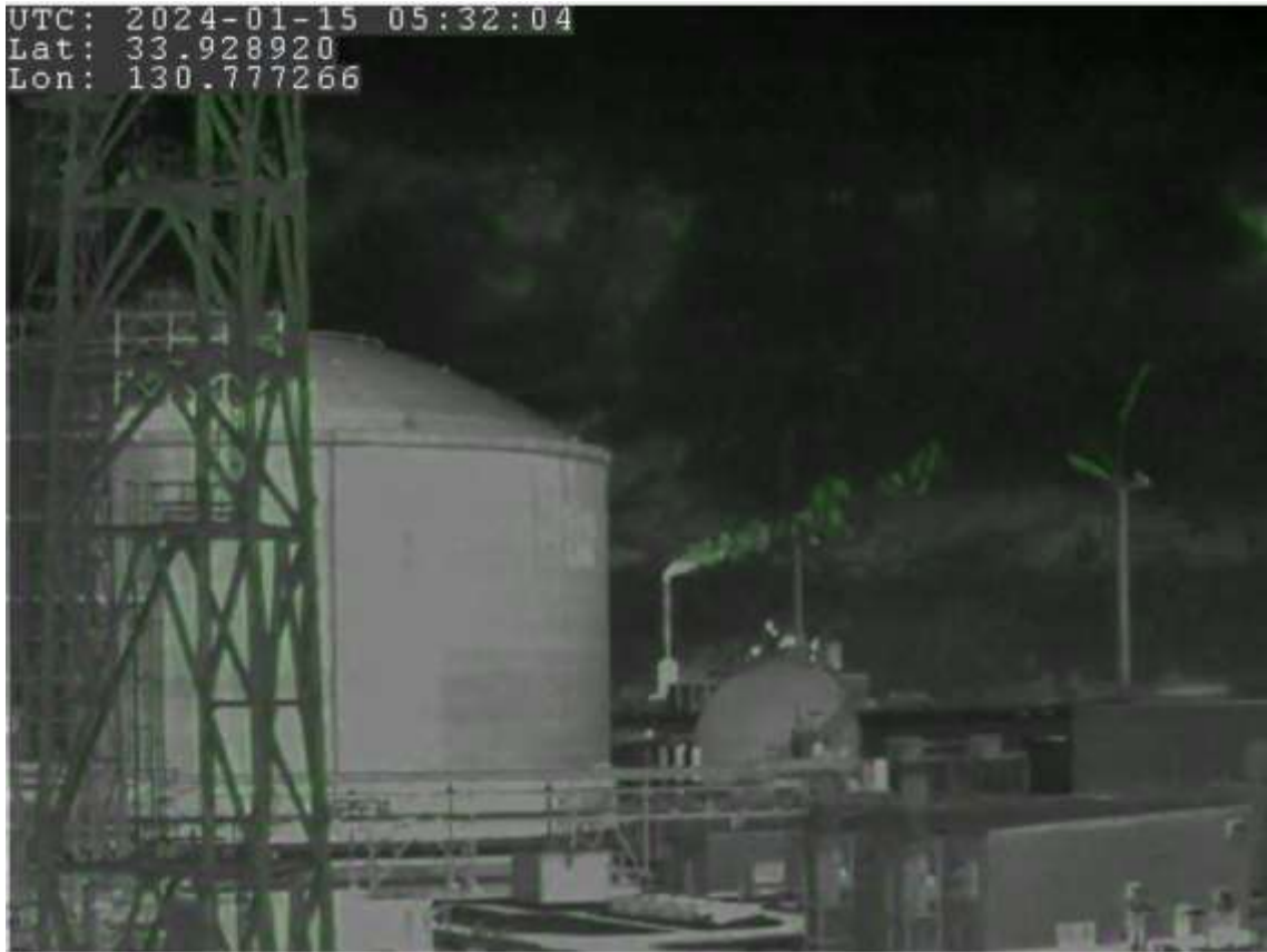
図 28 ガス検知カメラでの撮影状況
