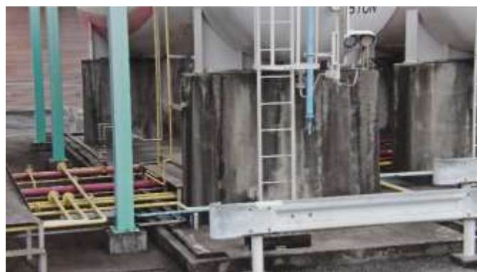
図 57 ドローンによる撮影が難しい点検箇所の例 (手前と奥のコンクリート基礎の間にある配管が、手前の基礎の陰になっている)
