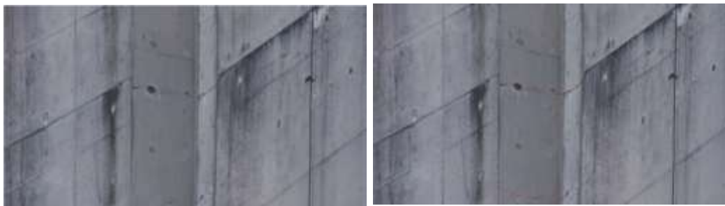
図 132 LNG 貯槽の側面のひびの AI 解析結果 1
