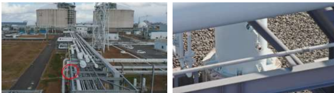
図 113 配管ラックと配管の上部からの撮影結果(左側:全景、右側:左の赤丸箇所の拡大図)
