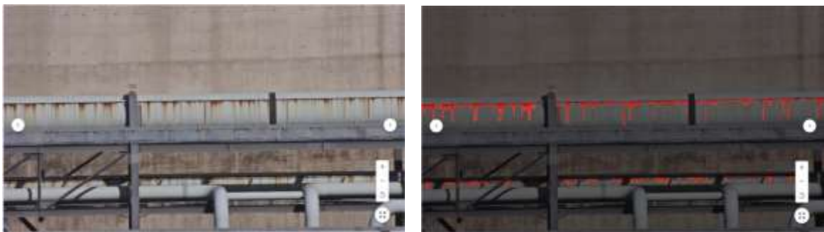
図 169 配管ラックの錆の AI 解析結果
