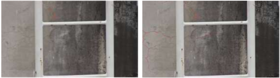
図 118 LPG 貯槽の基礎部分のひびの AI 解析結果 3 (赤線：検知されたひび)
