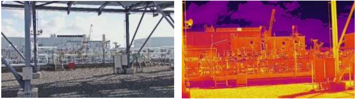
図 80 LPG 増熱器のサーマルカメラでの撮影結果
