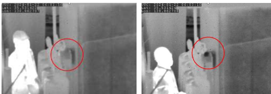
図 100 ガスメーターから（左）ガスを漏えいさせる前（右）ガスを漏えいさせた後
