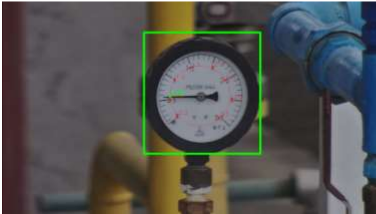
図 124 配管に設置されているメーターの AI 解析結果 1
