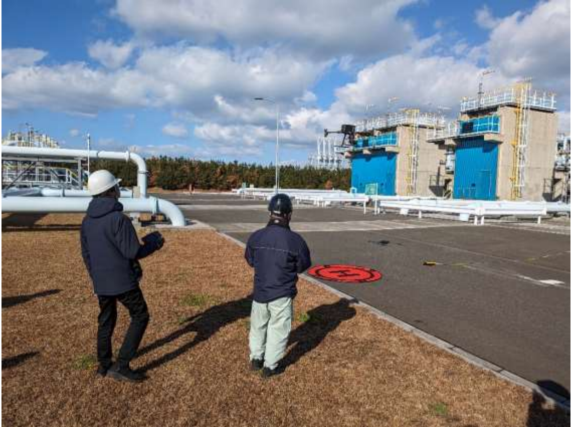
図 26 気化器の点検
