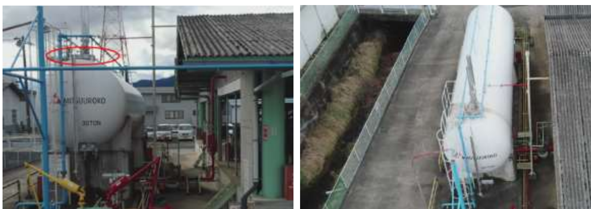
図 103 LPG 貯槽の上部全体の撮影結果 (左側:LPG 貯槽正面、右側:左の赤丸箇所について上からの撮影図)
