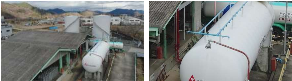
図 50 LPG 貯槽の上部の撮影結果(左側:全景、右側:拡大図)
