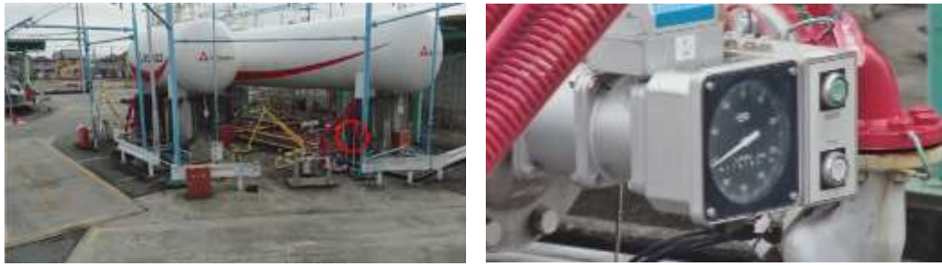
図 88 ローディングアーム付近に設置されている流量計の撮影結果 (左側:全景、右側:左の赤丸箇所の拡大図)
