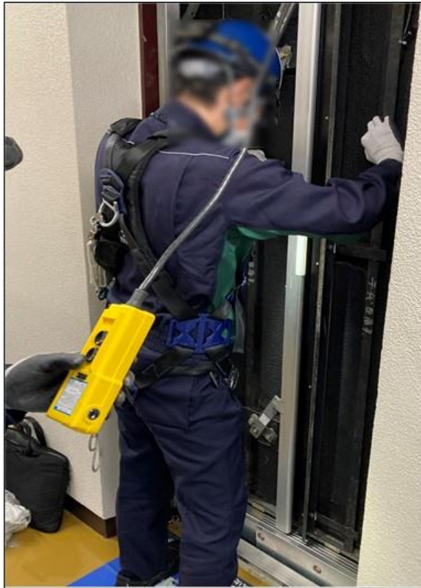
図 17 実証の様子：[従来手法]かごの運転の様子
