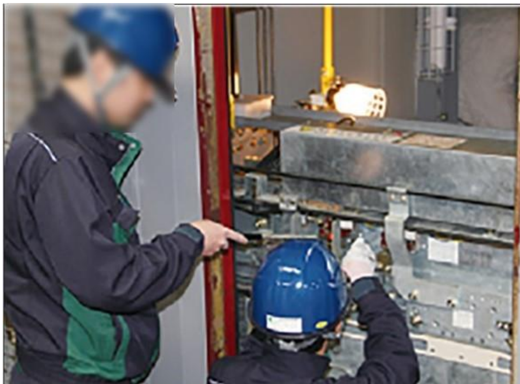
図 28 実証の様子：[従来手法]かごの戸のスイッチ
