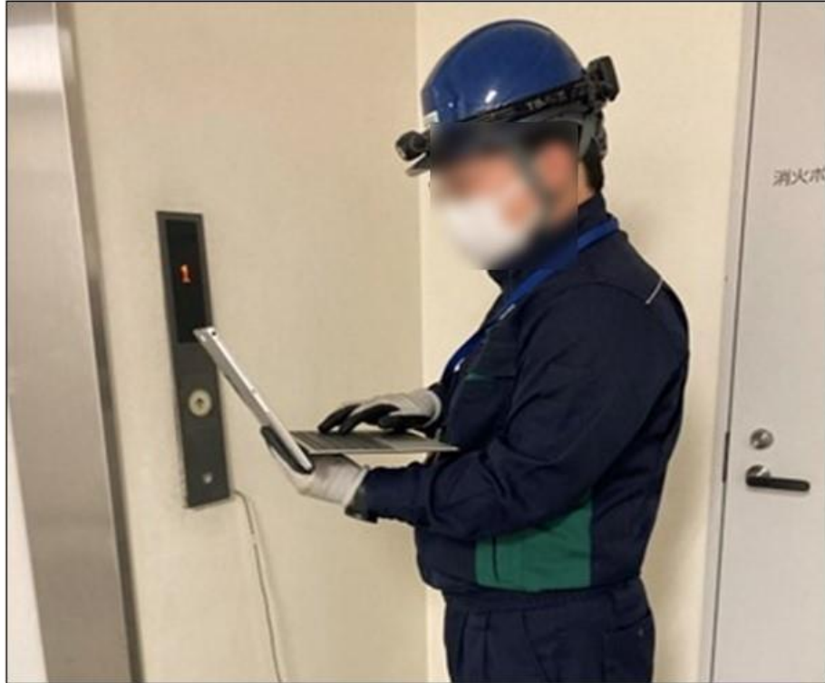
図 10 実証の様子：[デジタル化手法]乗り場での保守点検ツールを用いた検査の様子
