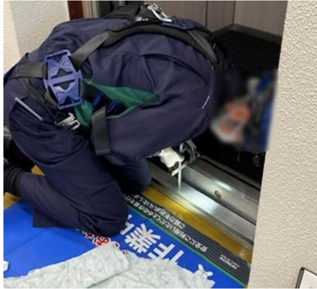
図 32 実証の様子：[従来手法] かごの床と乗り場の床の距離の計測
