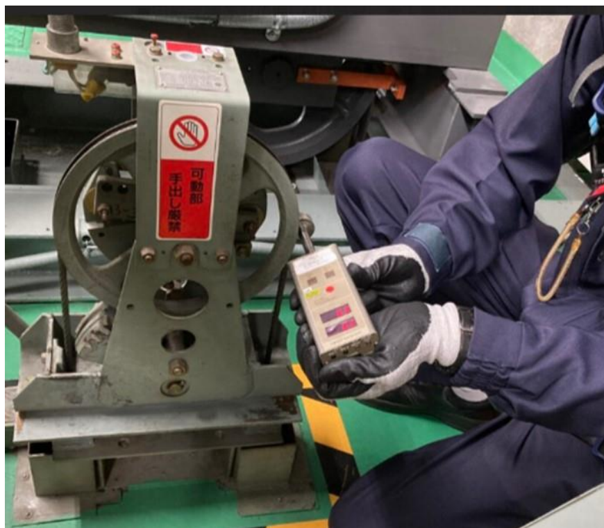
図 20 実証の様子：[従来手法]速度
