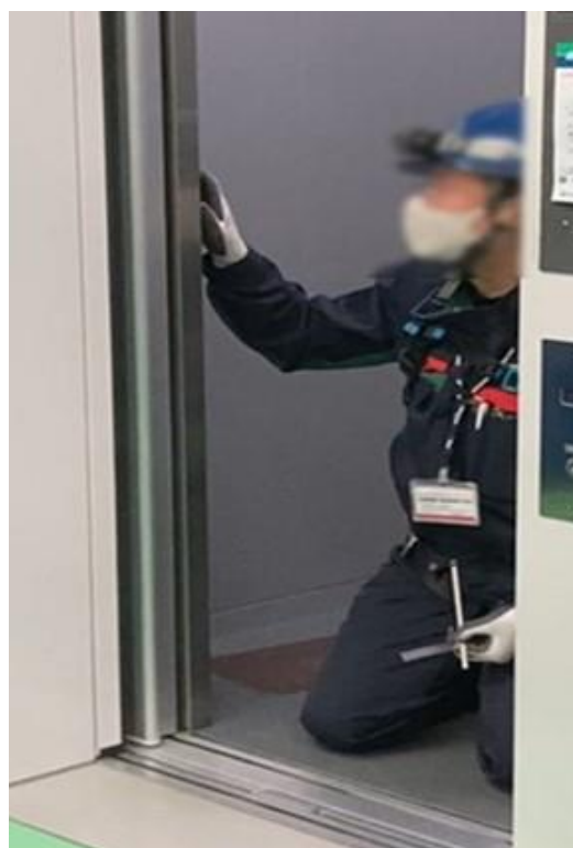
図 13 実証の様子：[従来手法]昇降機の作動状態の検査
