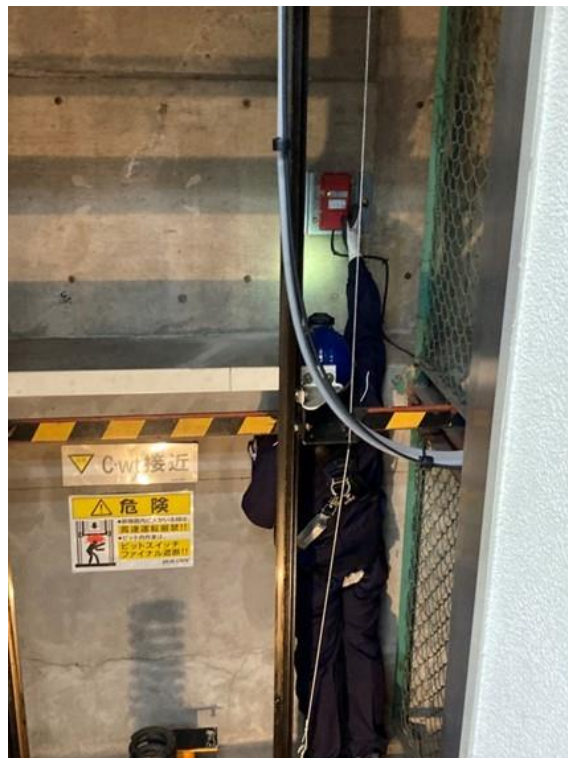
図 25 実証の様子[従来手法]地震感知器を反応させる作業(機械室無し)
