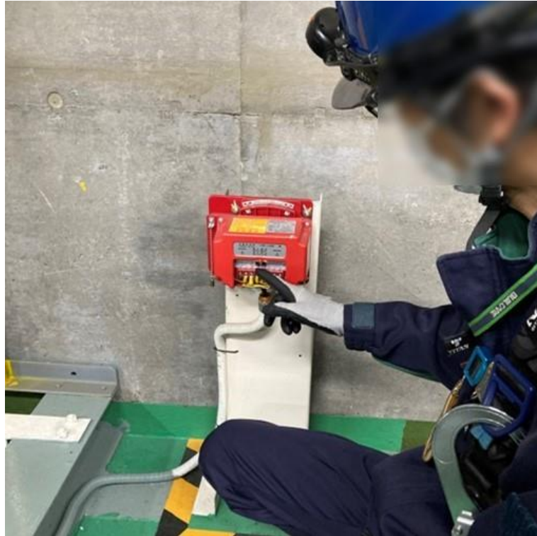
図 24 実証の様子[従来手法]地震感知器を反応させる作業(機械室有り)
