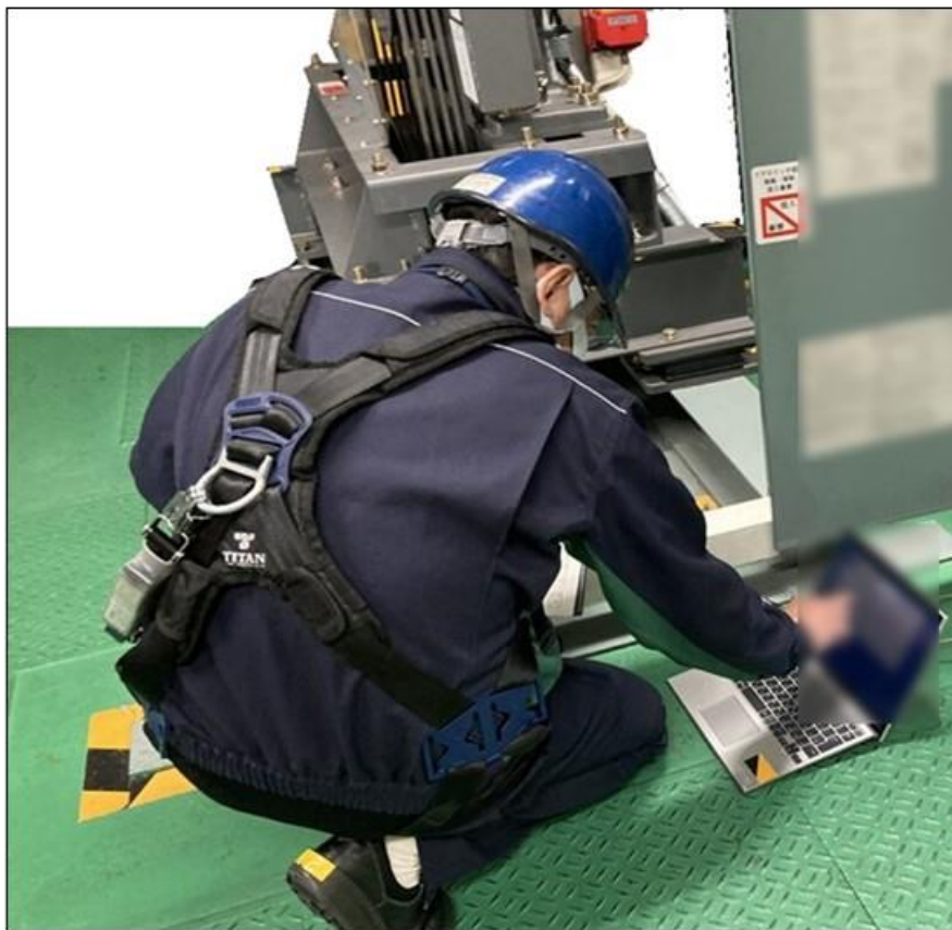
図 11 実証の様子：[デジタル化手法]機械室での保守点検ツールを用いた検査の様子
