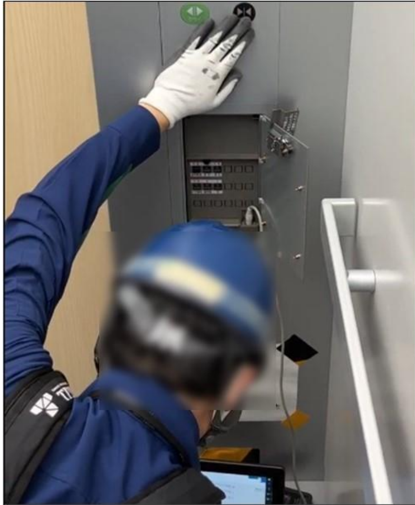
図 12 実証の様子：[デジタル化手法]かご内での保守点検ツールを用いた検査の様子
