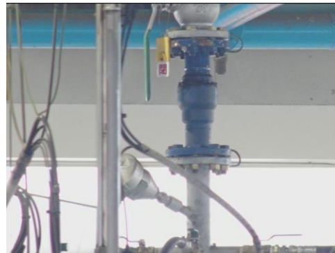
充てん機の室内設置のスイベルを 屋外から撮影した様子
