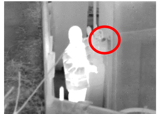
ガス検知カメラで低圧のガス漏れを 検知した様子
