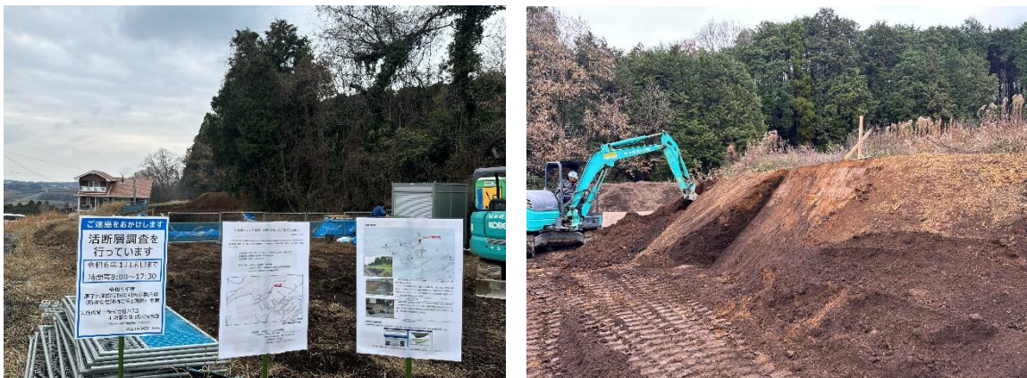
図 16 実証フィールドの周辺と盛土構造物の造成状況
