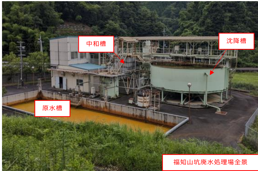
図 12 実証フィールドの全景(福知山坑廃水処理場)
