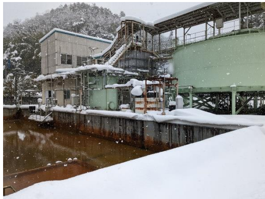
図 35 現地状況写真(1 月 25 日撮影)
