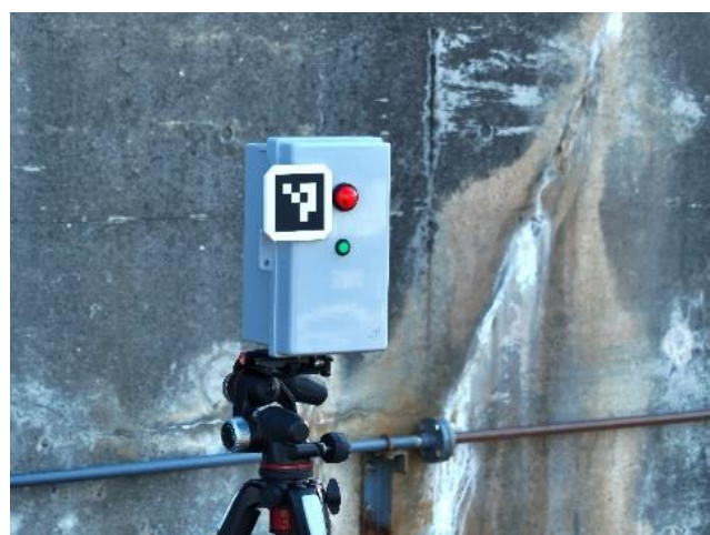
図 37 ガス漏洩警報設備のランプが ON の画像
