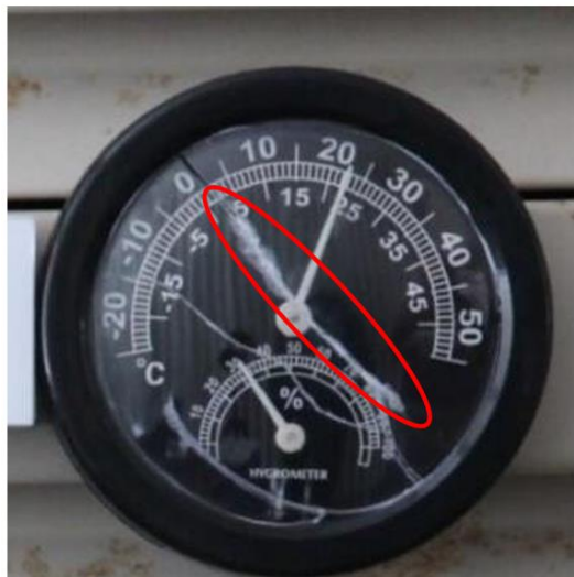
図 81 表面に傷や亀裂が入った計器
