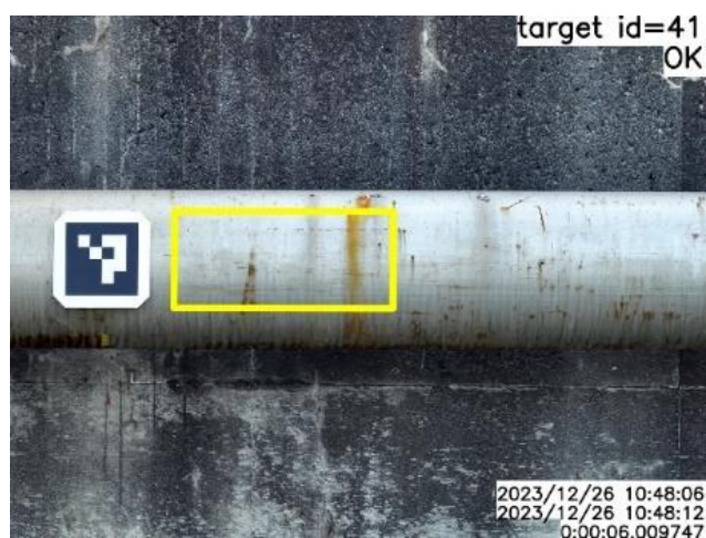
図 40 配管の劣化なしの画像※
