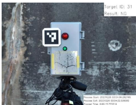
図 39 ガス漏洩警報設備の劣化ありの画像※
