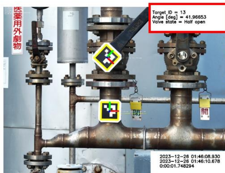
図 48 バルブ開閉の解析結果の例
