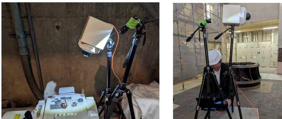
図 20 北川発電所での検証の様子
