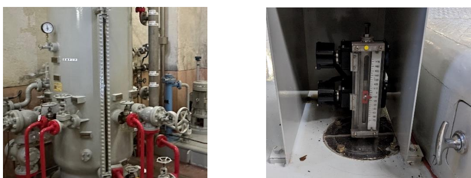
図 10 実証対象の棒状計器 (左：棒状油面計、右：棒状計器 (ポインタ型))
