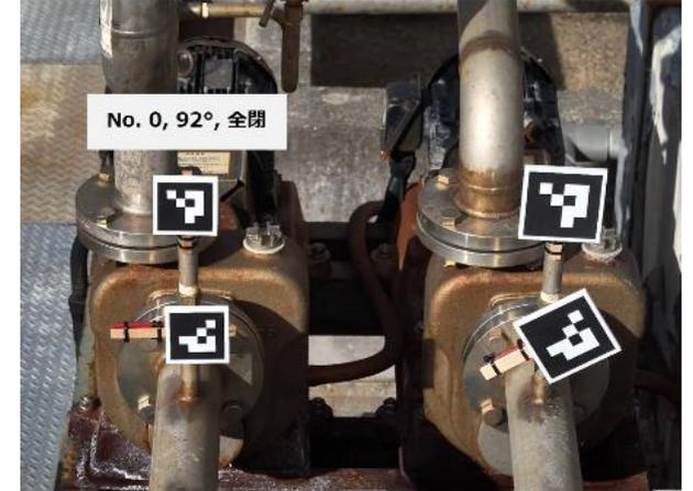
AI解析によるバルブの開閉状況の読み取り
