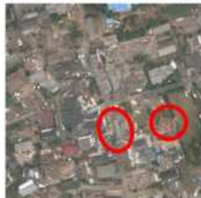
<平成28年熊本地震 被災後（2016年4月16日撮影）>
