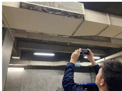
図 23 被検査側経年劣化、液漏れ等
