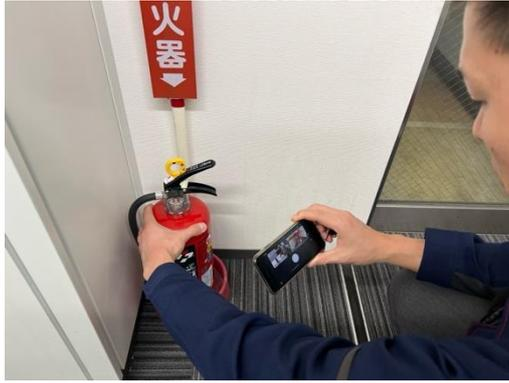
図 18 被検査側消火器使用期限確認の様子
