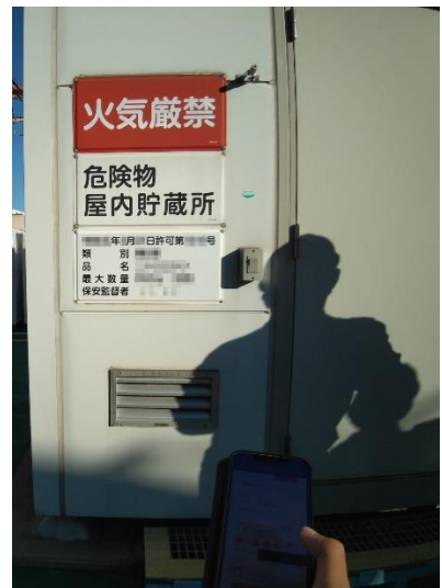
第三地点：高圧ガス製造事業所 危険物屋内貯蔵所
