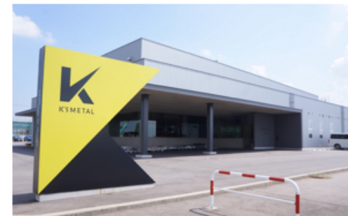
2021年竣工の新工場
